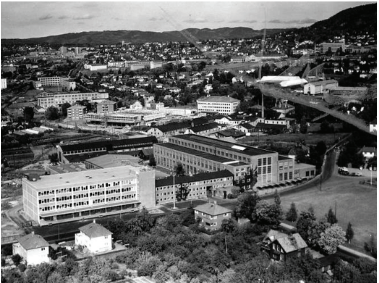
Industri (Per Kure) og bolig på hver sin side av Frydenbergveien. Foto:Widerøe/Oslo byarkiv
