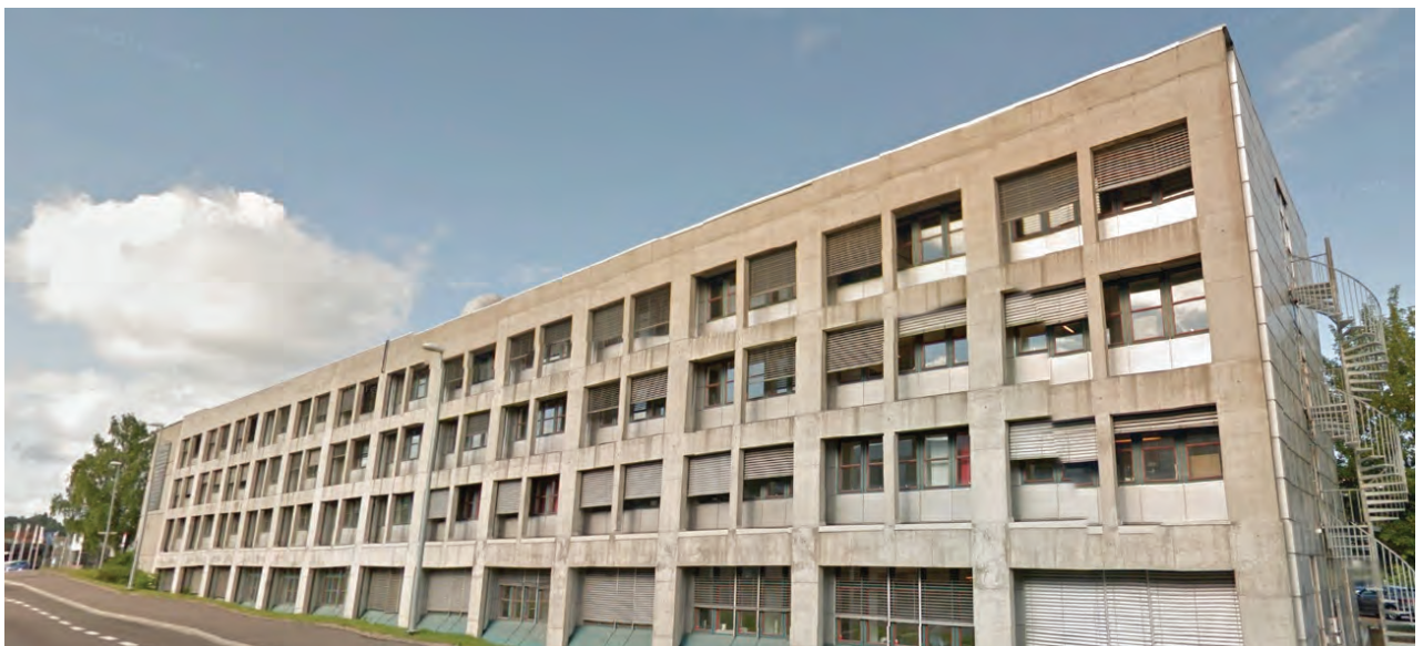
Kontorbygget i Ole Deviks vei 35 har arkitektoniske kvaliteter
