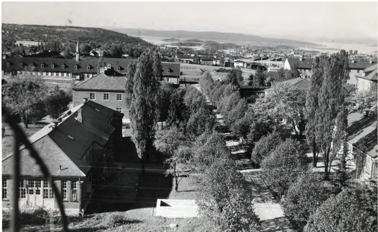
I forgrunnen poppelalleen med paviljonger på begge sider. I bakgrunnen det tyskbygde anlegget for venerisk syke offiserer. Bilde fra 1946: Oslo Museum
