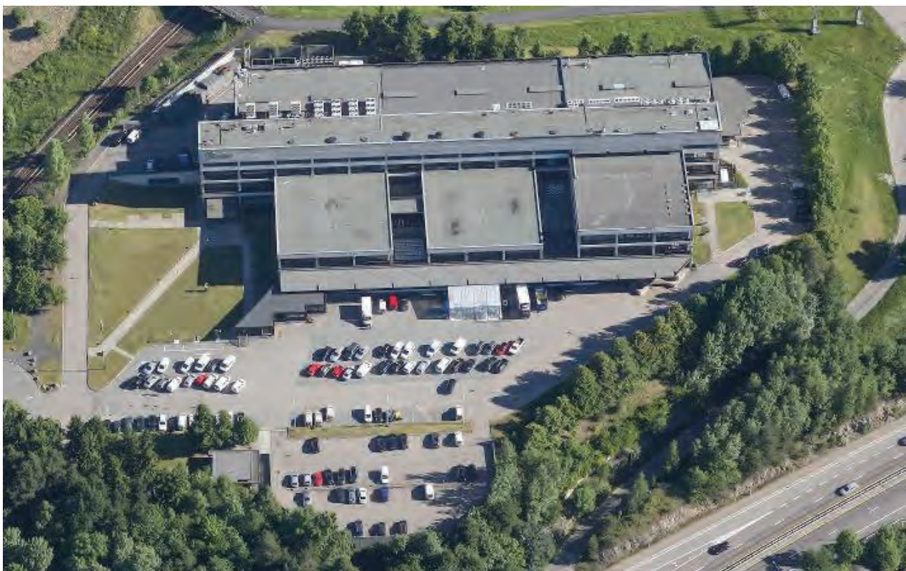
Anlegget ble oppført som trykkeri for Aftenposten i 1976
