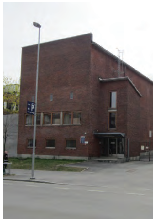
Transformatorstasjonen i Lørenveien
