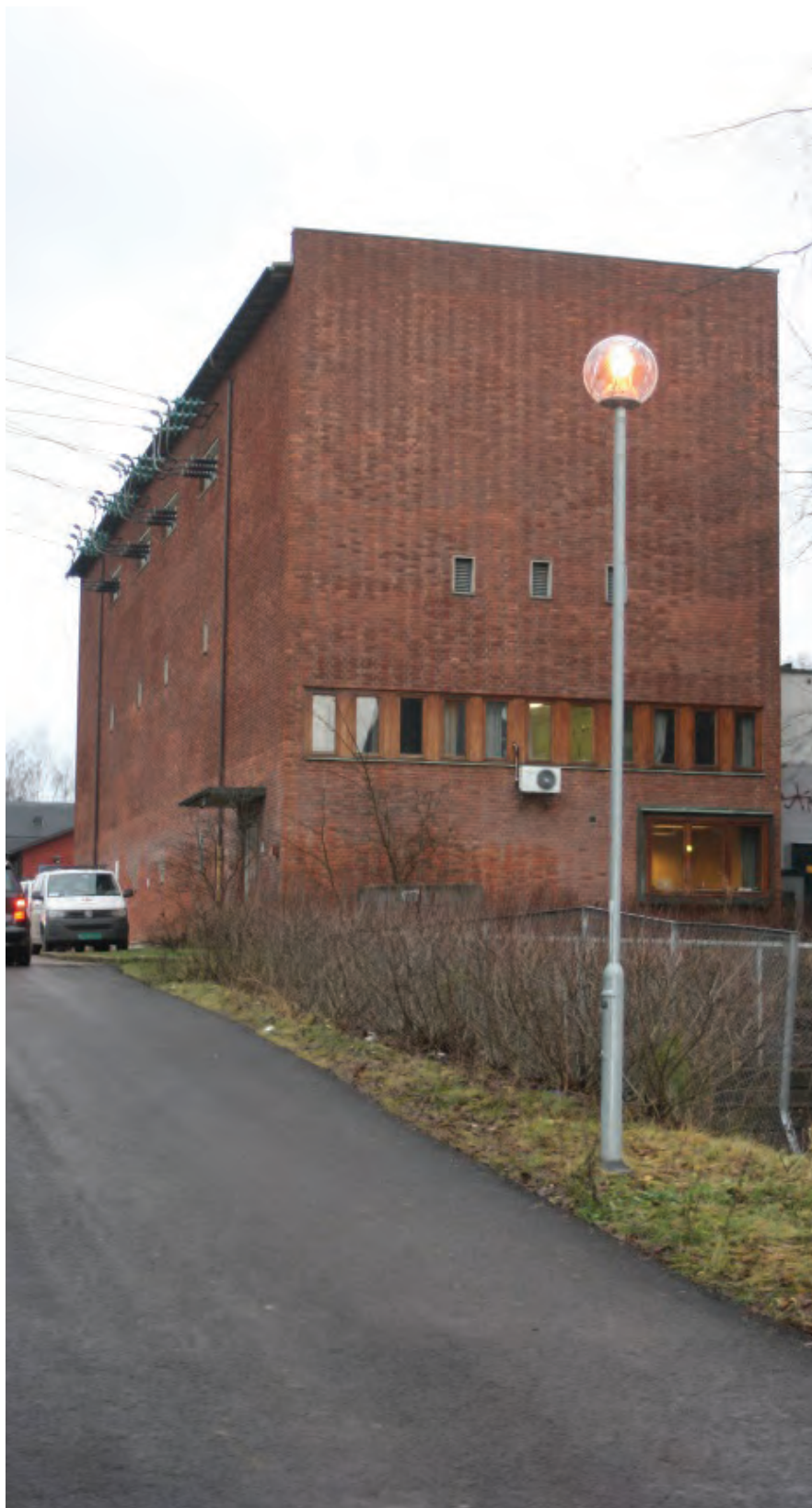
Transformatorstasjonen på Linderud
