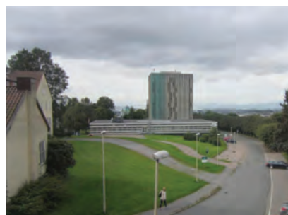
Det modernistiske anlegget stod ferdig i 1970 og var tegnet av arkitekt G. W. Thuesen
