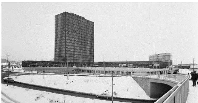
Vesta Hygea og Norsk Hydro fotografert i 1981. Økern senter i 1971. Nye planer åpner for riving av disse anleggene. Foto: Atelier Rude / Oslo Museum
